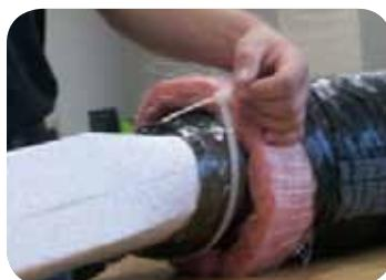
Raccorder les conduits flexibles isolés aux transitions isolés à l'aide des colliers de serrage. Tirez l'isolation et la barrière de vapeur des conduits au-dessus des transitions isolés. Sceller le joint avec un ruban adhésif sans comprimer l'isolation jusqu'à étanchéité complète.
