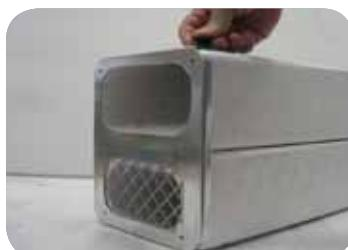
Raccorder les deux conduits de transition en les insérant dans la plaque de transition, à l'aide des quatre pinces de panneau en vinyle afin de fixer les conduits de transition isolés à la plaque de transition.
